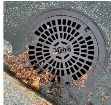
Tre spetthull gjør det fleksibelt å åpne lokket når det ligger for eksempel nært kantstein.
