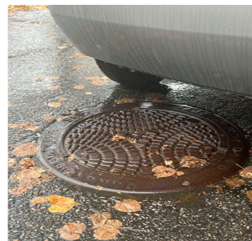
Tre spetthull gjør kumlokket mer tilgjengelig for å åpnes også om det skulle stå en bil parkert over lokket.
