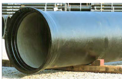
Sikre rørene med låseklosser.
