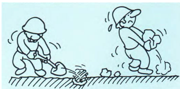
Fjern oppstikkende steiner
